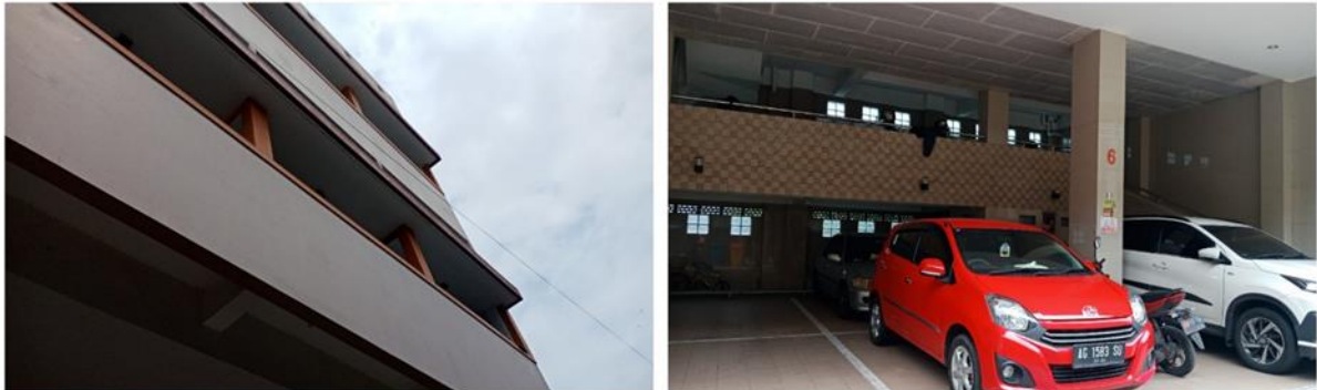
Jl. Jambangan Tama II No. 6
